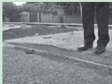
Иллюстрация пересечения с бетонным возвышением 10 см в высоту и 1 м в длину, позволяющим добиться желаемого снижения скорости (30 км/ч).
