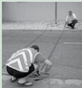
Индуктивные петлевые датчики вкладываются в асфальт по поверхности проезжей части, заделываются и подключаются к регистратору данных, который размещен в ящике на обочине дороги. Поскольку измерительные кабели уложены в асфальт, они не истираются транспортными потоками. В зависимости от потоков и возможностей регистратора, оборудование может неделями находиться без присмотра.
